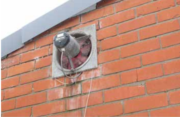
Een ventilator gemonteerd op de buitenwand stuurt continu verse lucht naar binnen.
